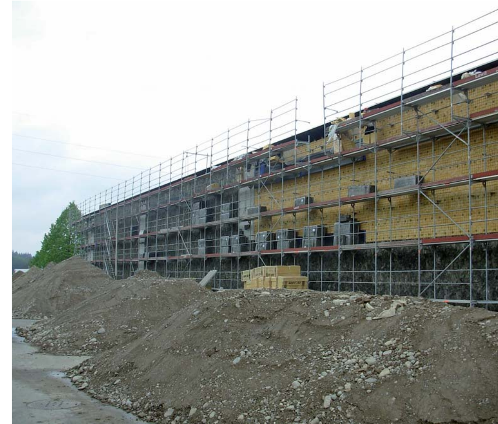
Anbringen der 2-lagigen Wärmedämmung (für Minergie P)
