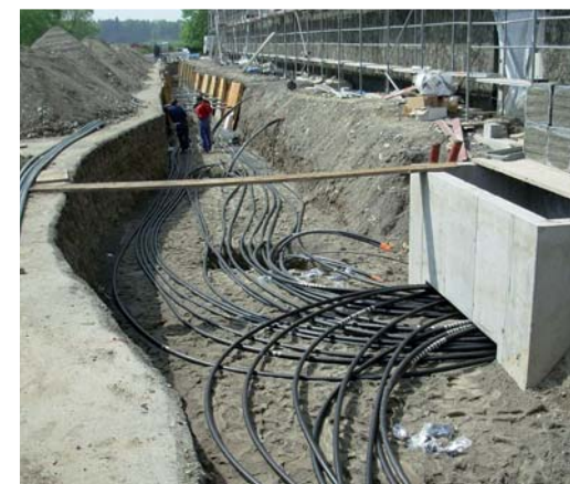
Geothermale Bohrungen (Erdwärmesonden)
