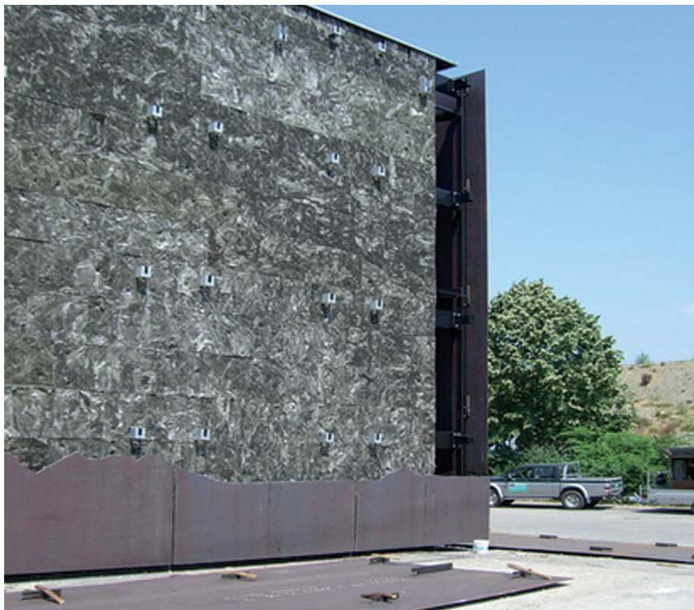
Wärmedämmung und Stahlplattenverkleidung
