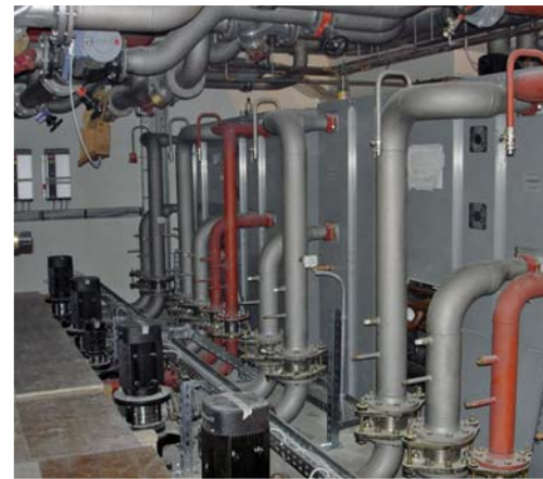
Verrohrung der Wärmepumpen (Rohinstallation)
