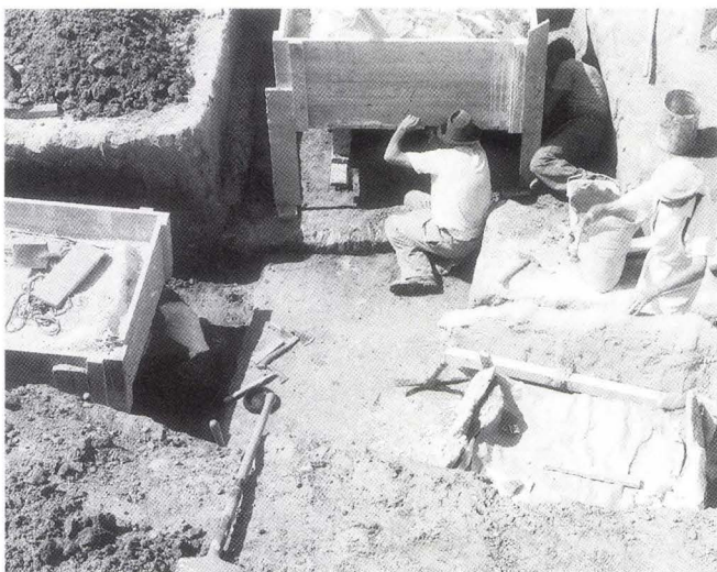
Abb. 15, Fig. 1–5 Bergungstechnik, vorbereitende Arbeiten für Hebung und Transport der Steinkistengräber ins Landesmuseum. Fig. 1 Isolation und Verschalung der Platten sowie Einzelentnahme derselben bei Überschreitung der Türmasse der vorgesehenen Präparationsräume; Fig. 2–3 die verschalten und eingegipsten Gräber werden in streifenweiser Unterfang-
